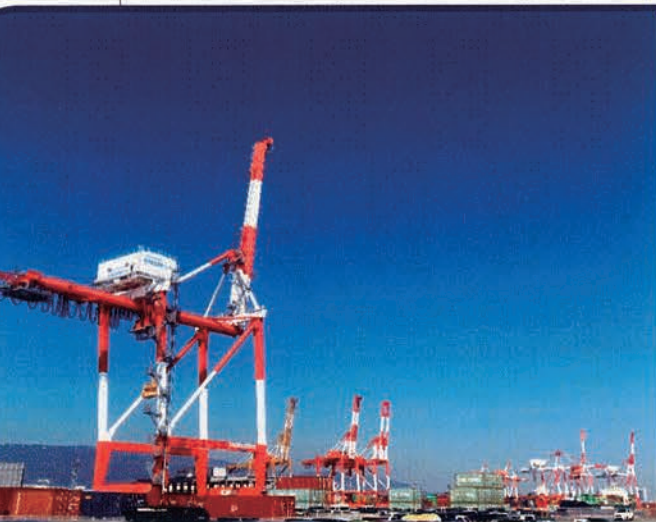
ガントリークレーン (通称: キリン) 神戸港 2023年11月撮影
