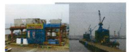
建設途中のケーソン(右)と遠隔ドリルコントロール室(左)
