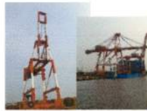
作動しているガントリークレーン(右)と作動していないガントリークレーン(左)。
