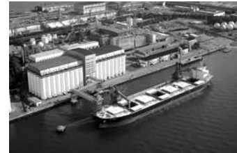
貯蔵槽倉庫 (サイロ)
