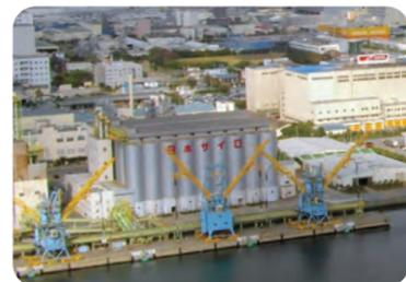
千葉食品コンビナートは、食品工業の近代化・合理化を図るための食料工業団地で、千葉市新港地区にあります。臨海部にサイロ群を設け、大型船により海外からの原料を大量に受入れ、その後方に原料加工企業や加工食品企業等が配置されています。
